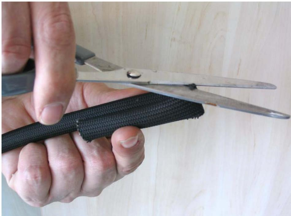
**Achten Sie darauf, dass der Hitzeschutzschlauch ganz hinten sitzt und kein Kabel freibleibt, da Kabel sonst im Betrieb beschädigt werden können.**
